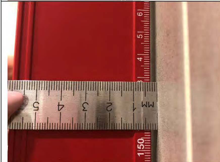
Фото №20. Измерение уровня стен ванной комнаты в квартире.
