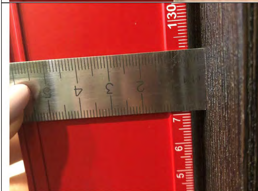
Фото №11. Измерение уровня полотна входной двери в квартире.
