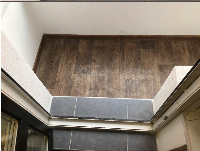
Фото №6. Общий вид лоджии в квартире.
