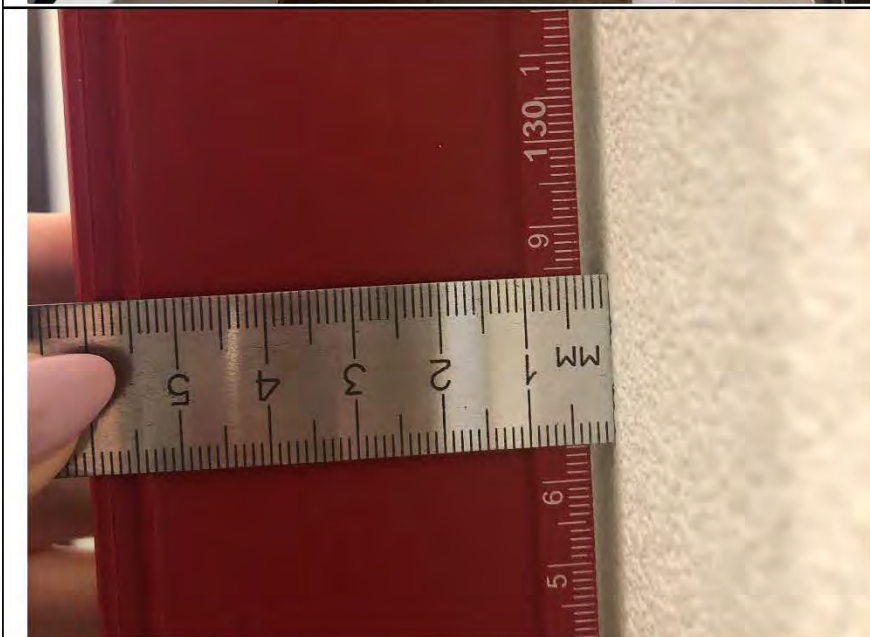
Фото №8. Измерение уровня стен коридора в квартире.
