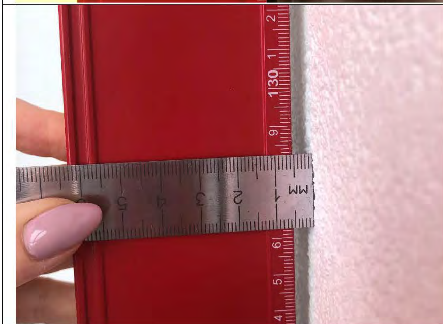
Фото №15. Измерение уровня стен лоджии в квартире.
