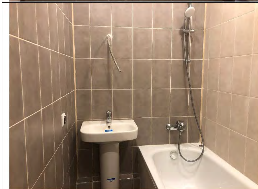
Фото №3. Общий вид ванной комнаты в квартире.
