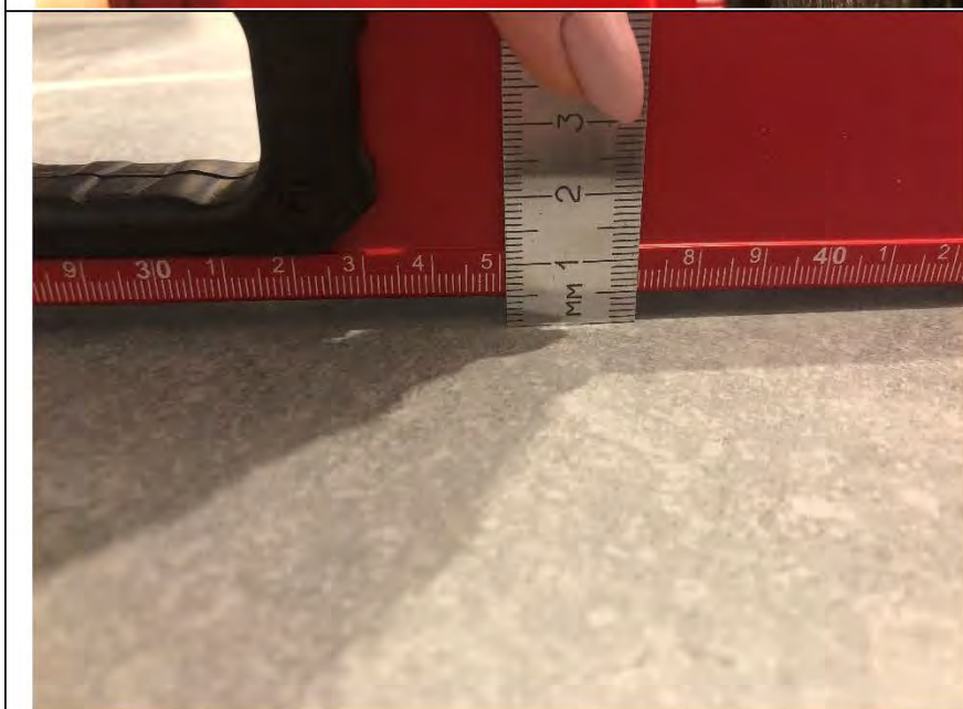
Фото №12. Измерение напольного покрытия коридора в квартире.
