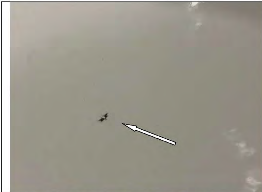
Фото №73. Скол на покрытии ванной и ванной комнате.
