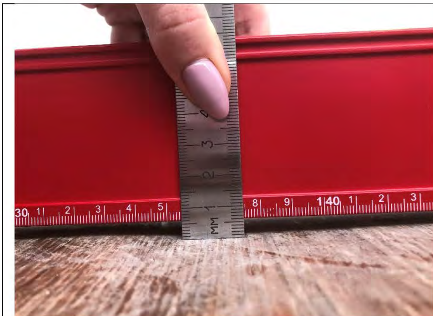
Фото №16. Измерение напольного покрытия на лоджии в квартире.
